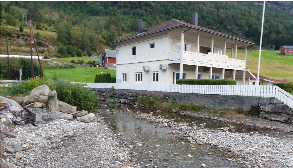
Figur 3 - Eksisterende bebyggelse langs utløpet av Vikaelva
