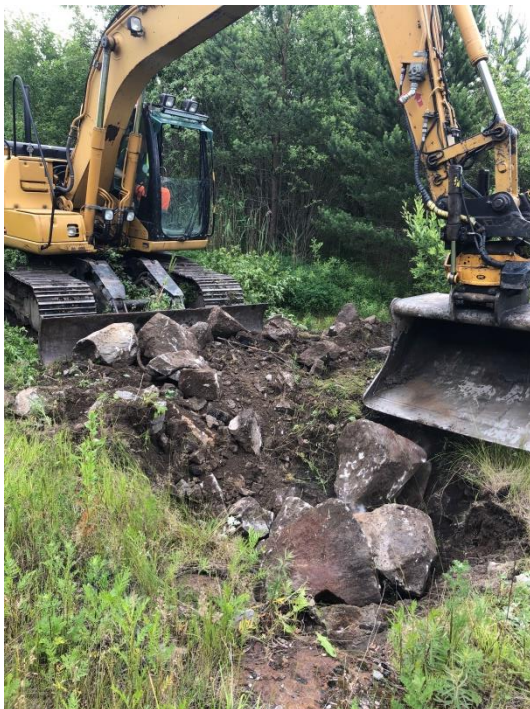
Figur 5: I punkt 3 var det svært mye stein, slik at vi ikke fikk gravd helt ned til 1,5m.
