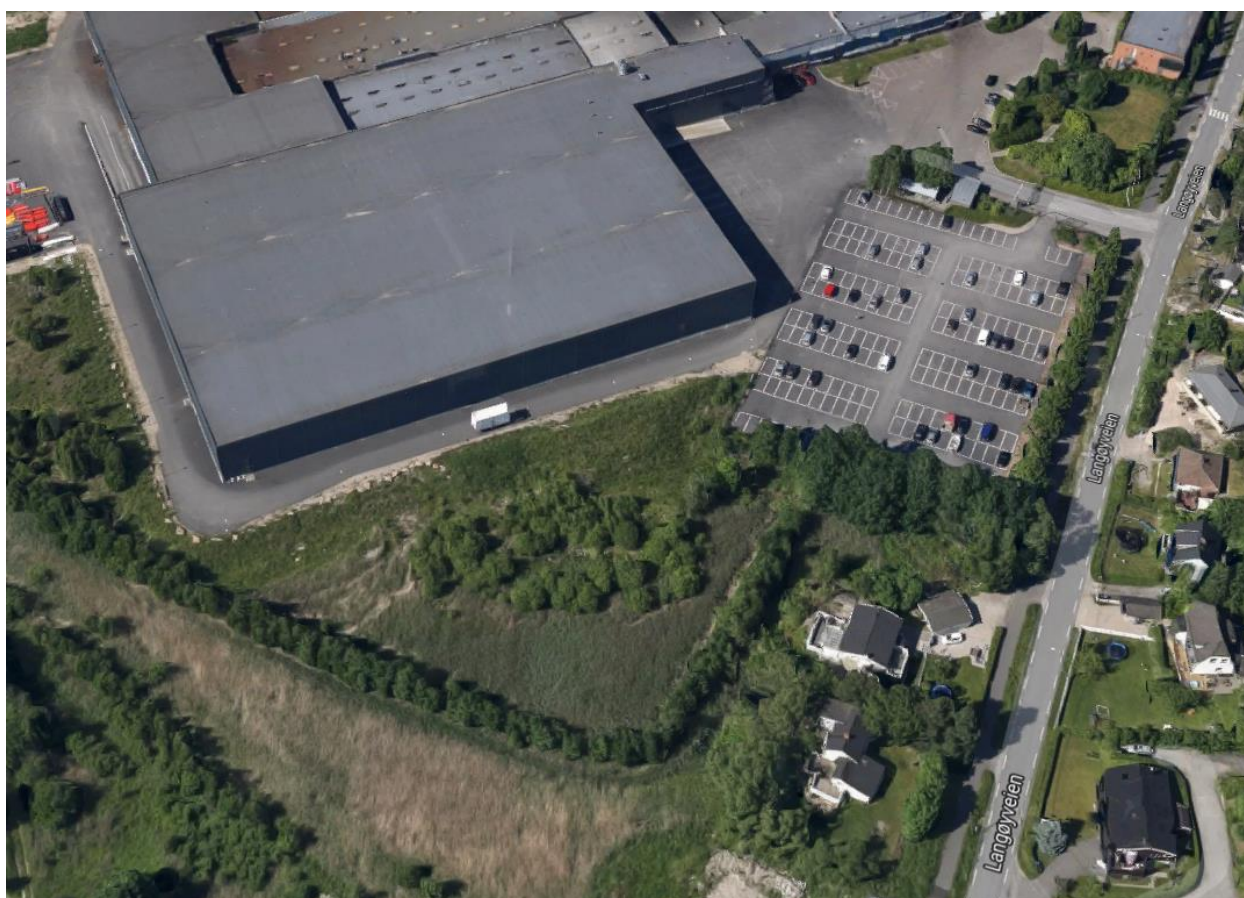
Oversiktsbilde over tiltaksområdet Jøtul AS
