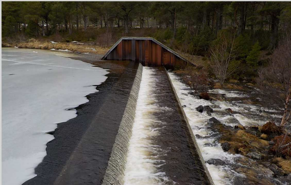
Bilde 14 Overgang østre damdel mot vangemur av spunt
