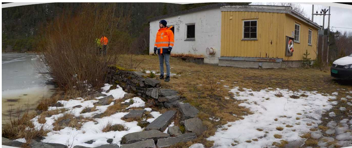
Bilde 9 Område ved pumpehus
