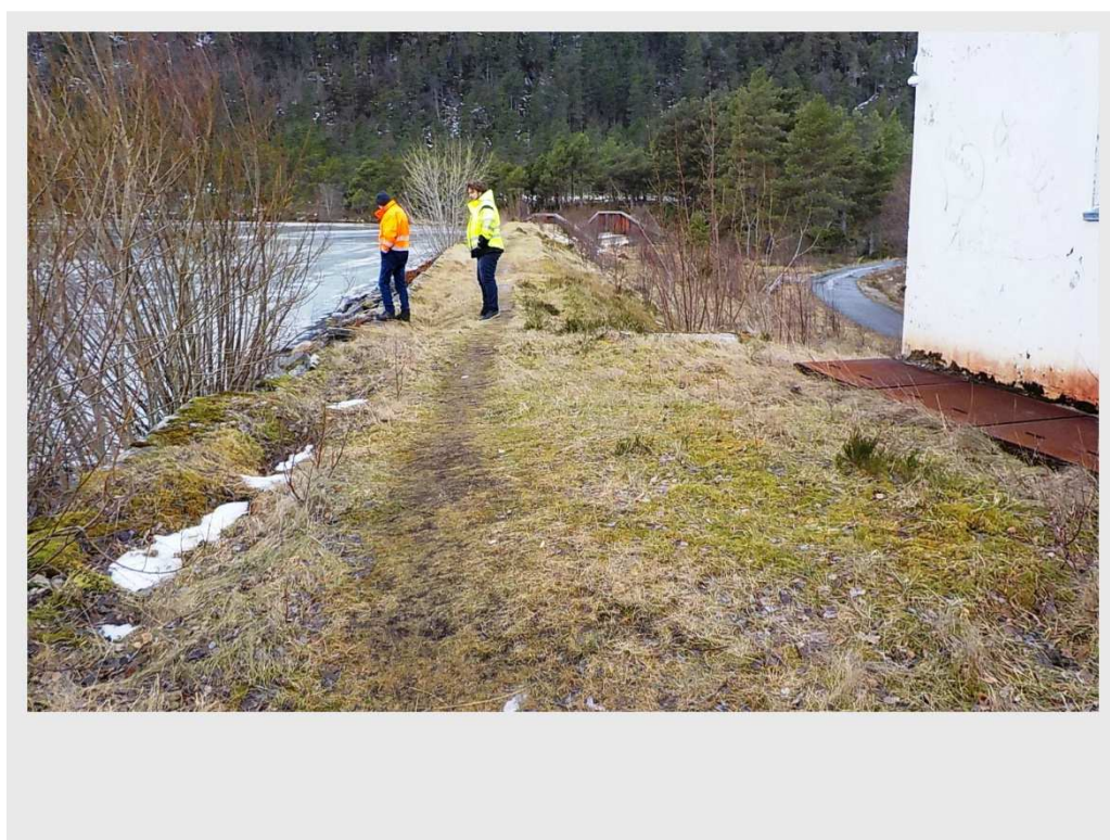
Bilde 10 Damkrona sett vestover fra pumpehuset
