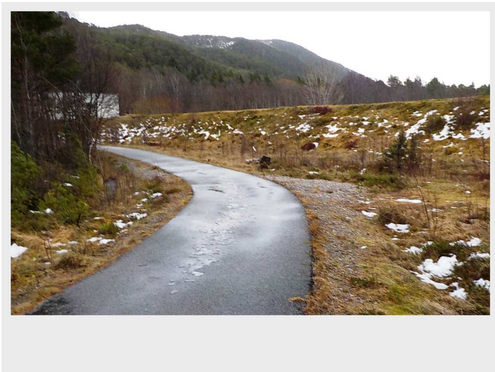
Bilde 17 Vei nedstrøms dammen.
