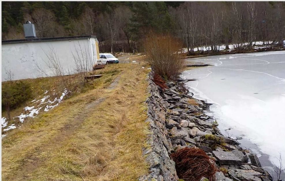
Bilde 12 Område nedstrøms eksisterende dam sett fra pumpehus vestover
