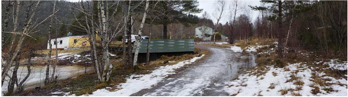
Bilde 23 Naust, pumpehus og dam sett fra gangvei sett medstrøms
