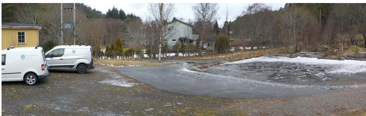
Bilde 3 Område ved pumpehus
