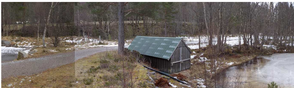
Bilde 4 Område ved pumpehus - fortsettelse sørøstover fra forrige bilde
