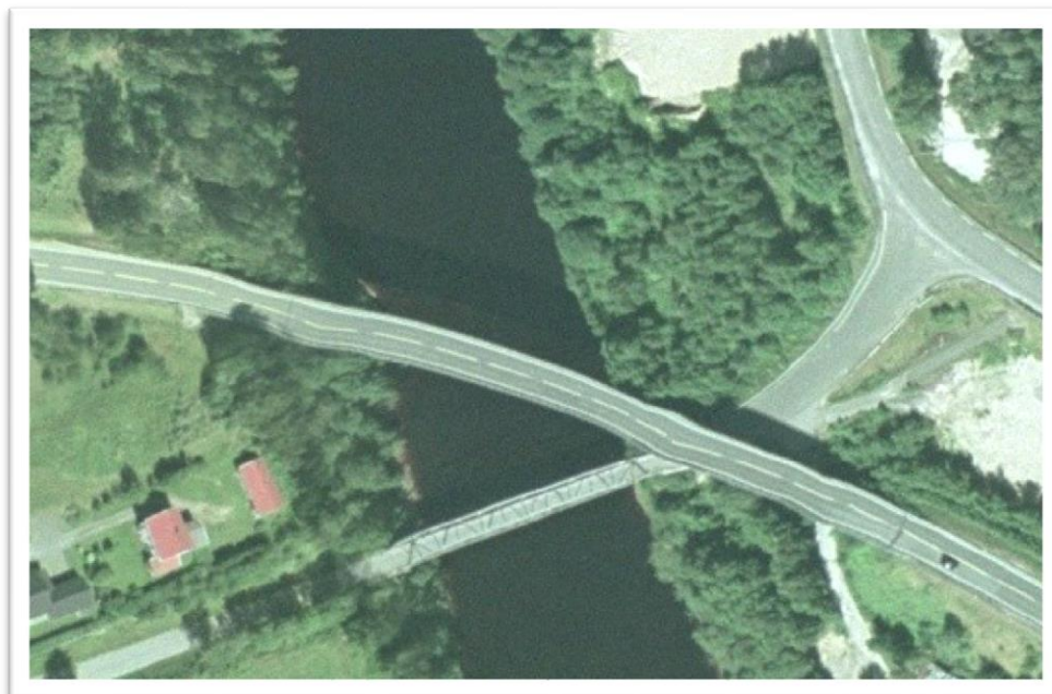
Figur B.6: Eksempler som viser at terrenngmodellen ikke er justert ved tekniske anlegg (bru). Broene får et bølgemønster eller blir sterkt fortegnert, noe som ikke aksepteres.
