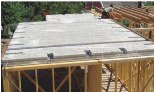
Hulldekke i betong.
