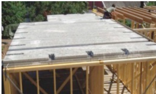
Hulldekke i betong
