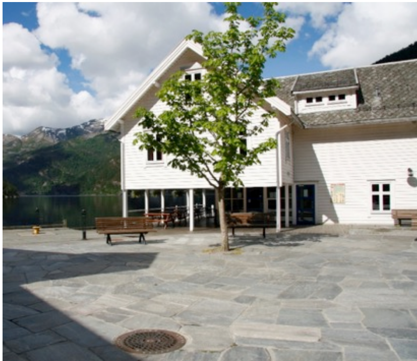
Fig.2. Eksisterende skiferbelegg av bruddheller ved Mobryggja.
