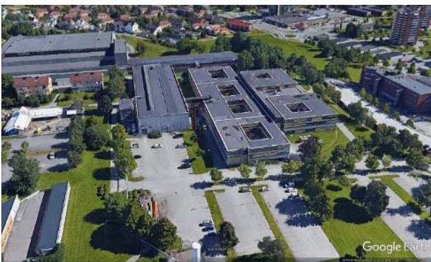
Figur 5.12 Marinteknisk senter, sett mot nordøst (Google Earth)
