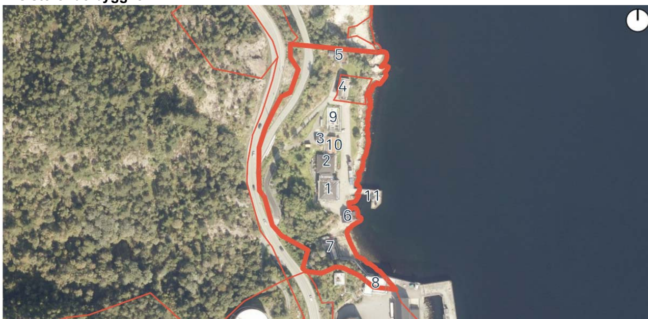
Figur 5.4 Eksisterende byggverk på byggetomten
