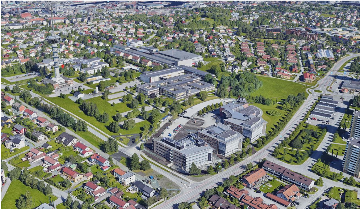
Flyfoto sett fra sør-øst
