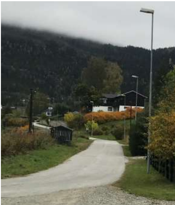
Bilde viser berørte gatelysmaster
