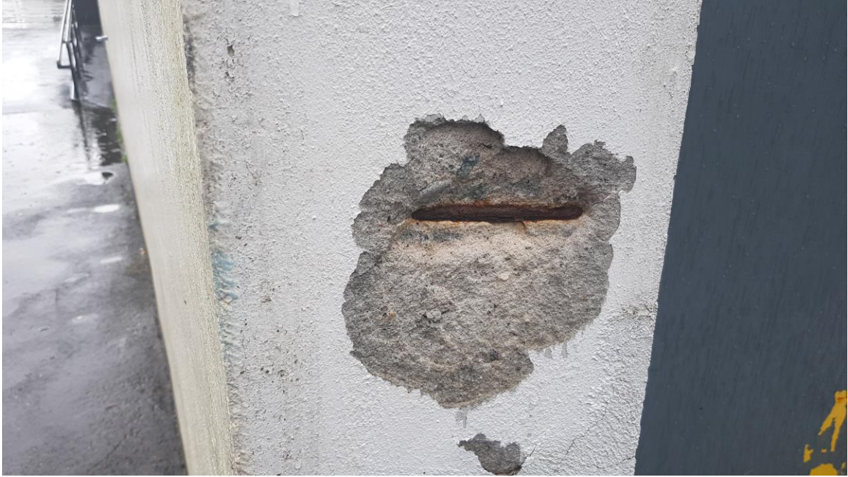
Bilde nr. 5- Utvendig hjørne i akse A-1.
