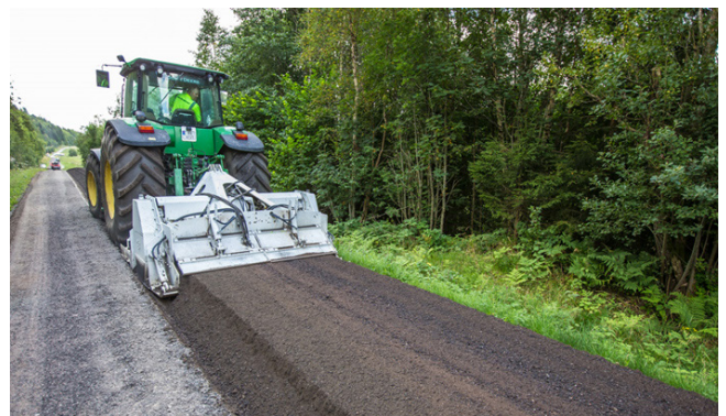
Gjenbruk av frest og knust asfalt på bygdevei. Foto: Anleggsmaskinen.no/Crusher.no
