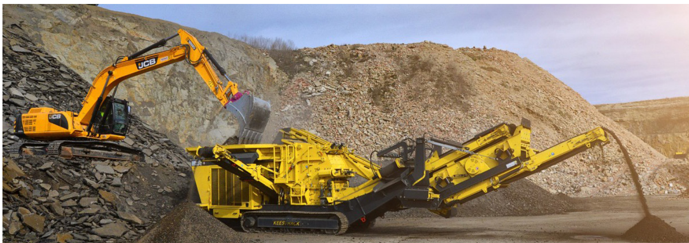
Stein, betong og asfalt kan enten transporteres til sentralt anlegg eller knuses på stedet. Nedknust asfalt tilsettes i produksjonen av ny asfalt eller brukes som toppdekke på landbruksveier. Foto: Fredheim maskin AS
