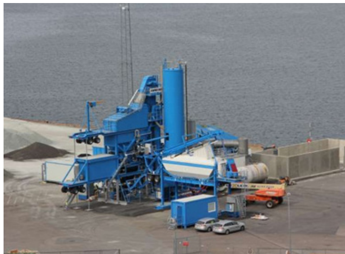
Mobilt asfaltverk på Ormsund. Råstoffene fraktes til anlegget med båt. Foto: NCC
