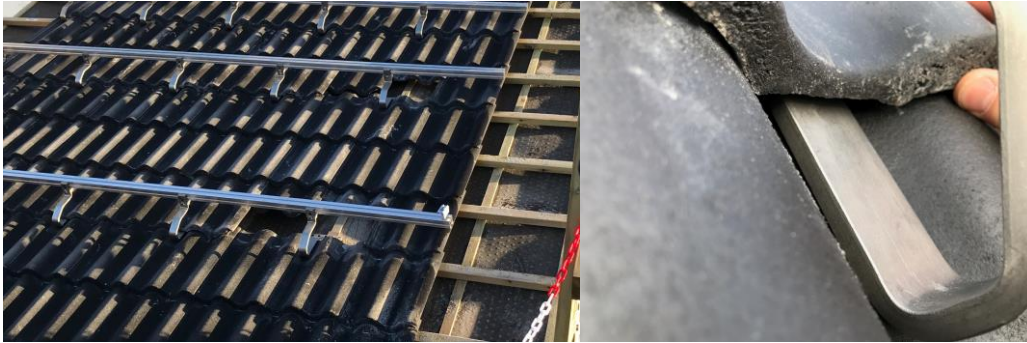
Figur 10 Skinner for montasje av paneler, venstre. Festebrakett som går inn mellom taksteinene, høyre.
