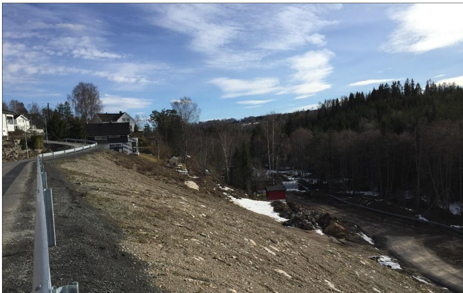
Fig. 2-7 Bilde fra Kongslia der tunnelportalen skal bygges mellom gs-veien til venstre i bildet og Dalsbekken til høyre. Foto: Sweco mars 2019.
