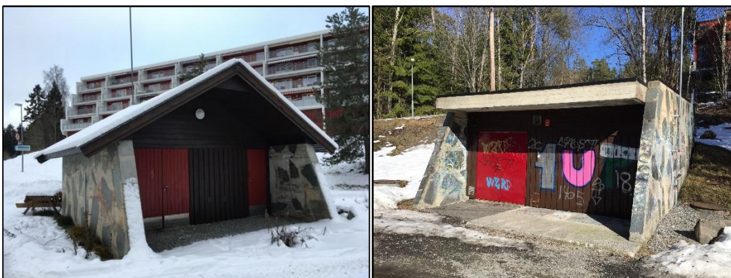
Figur 12: Fosstjern pumpestasjon til venstre og Vevestad PSP til høyre. Foto: Sweco 2018 og 2019.
