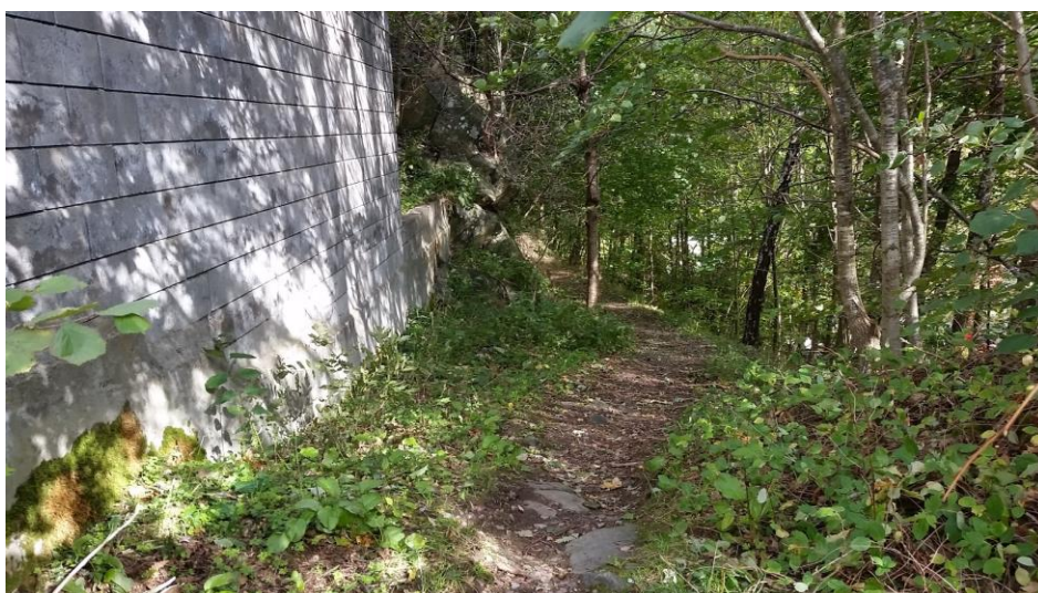
Figur 16 Trase 1-A, sett nordover ved ca pr. 100
