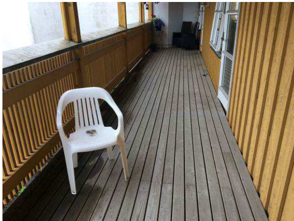
Foto 25: Balkong i bygg C
