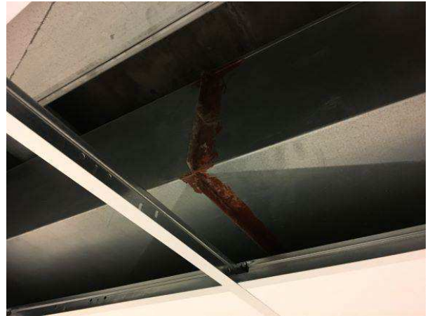
Foto 36: Prøve nr 2 – tettemasse. Påvist asbest.
