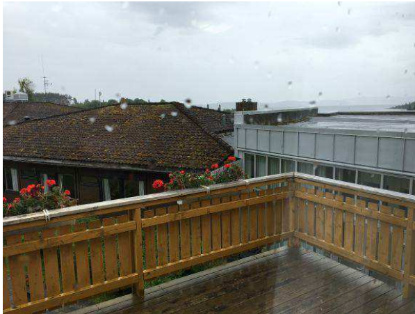
Foto 29: Tak bygg D
