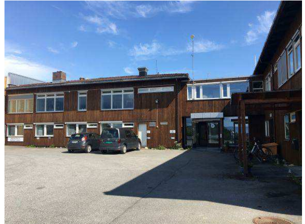
Foto 2: Fasade bygg D
