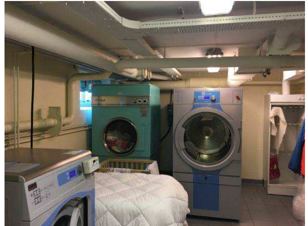
Foto 30: Vaskeri i sokkel bygg C
