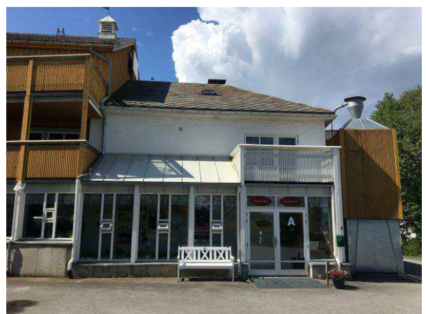
Foto 16: Fasade bygg C
