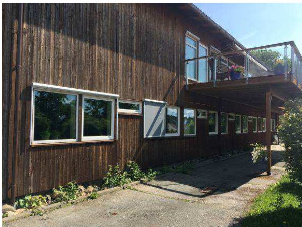
Foto 3: Fasade bygg D
