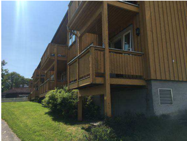
Foto 17: Fasade bygg A
