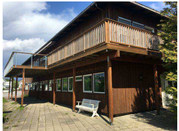
Foto 4: Fasade bygg D
