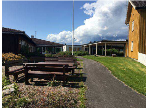
Foto 8: Fasade bygg D
