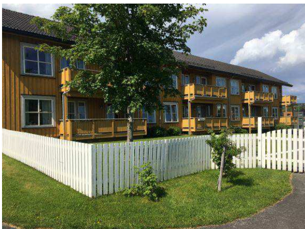
Foto 9: Fasade bygg A
