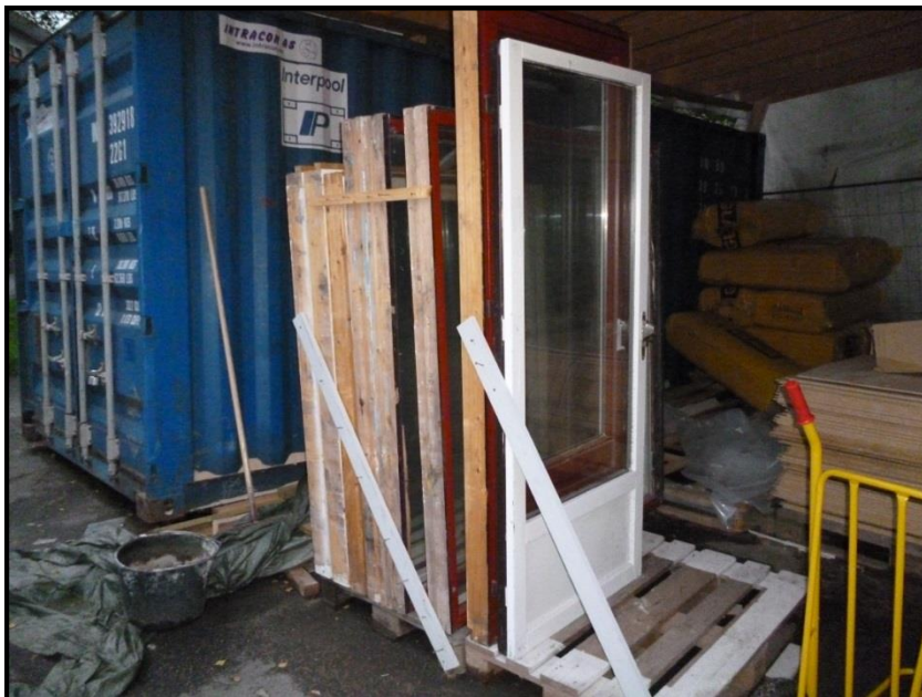
Figur 2: Slik kan vinduer og balkongdører klargjøres for transport.
