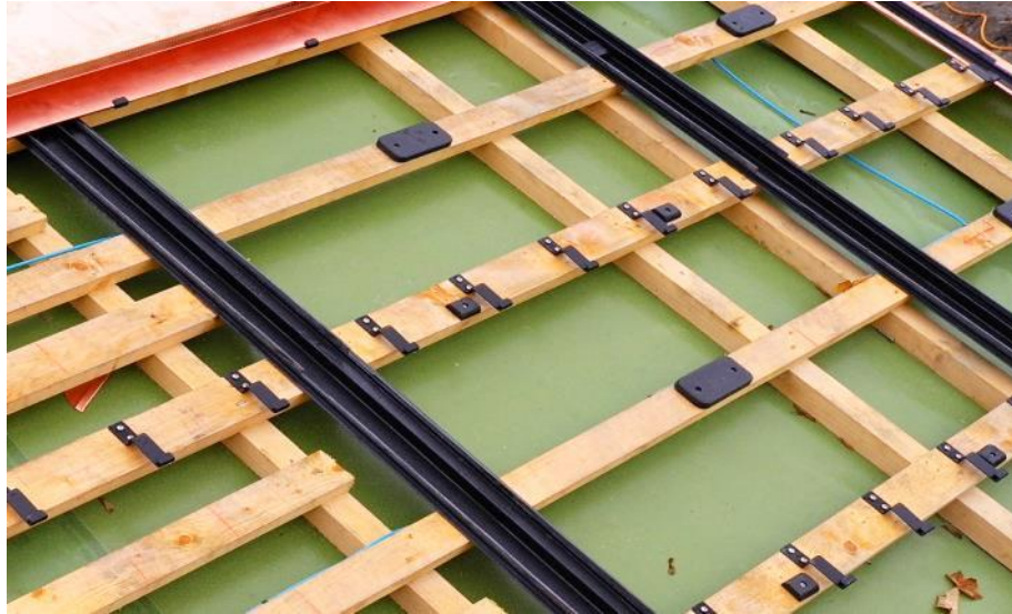
Figur 8: Underkonstruksjon for Mega Slade Alpin, som er et BIPV solcelletak som tåler høye snølaste. Kilde: 3S Solar Plus.
