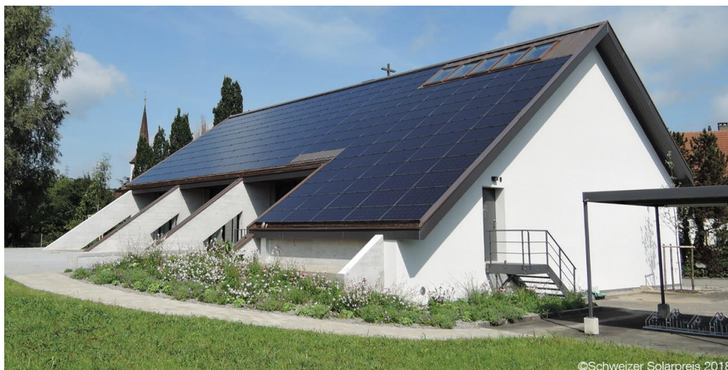
Figur 7: Bygningsintegret solcelleanlegg fra 3S Solar Plus på en kirke i Sveits.
