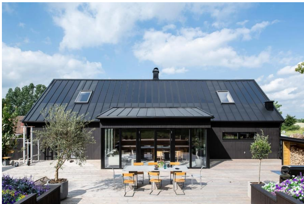
Figur 6: Bygningsintegret solcelleanlegg fra Lindab SolarRoof.
