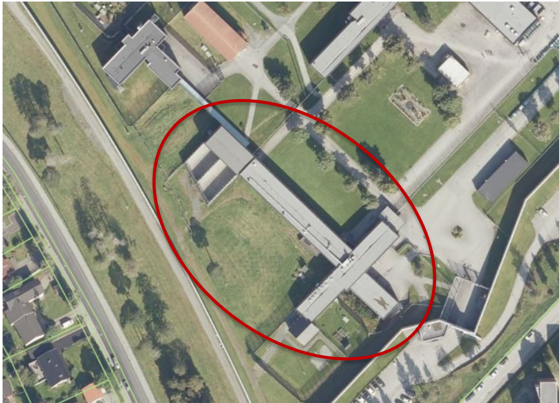
Figur 2 Flyfoto som viser Bygg A ved Trondheim fengsel. Kilde: Trondheim kommunes karttjeneste.
