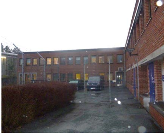
Figur 4 Fasade mot øst.
