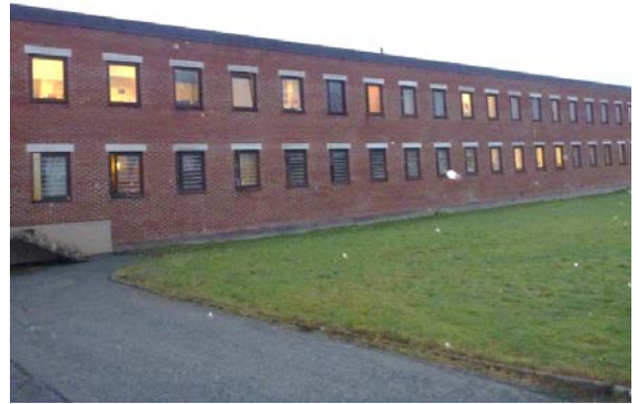
Figur 5 Fasade mot nord.
