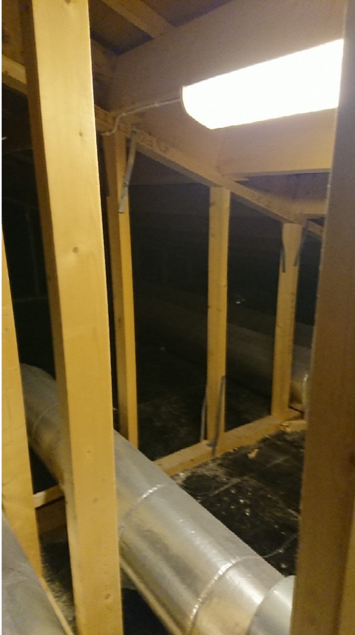
Bilde tatt av takkonstruksjon i akse H-I
