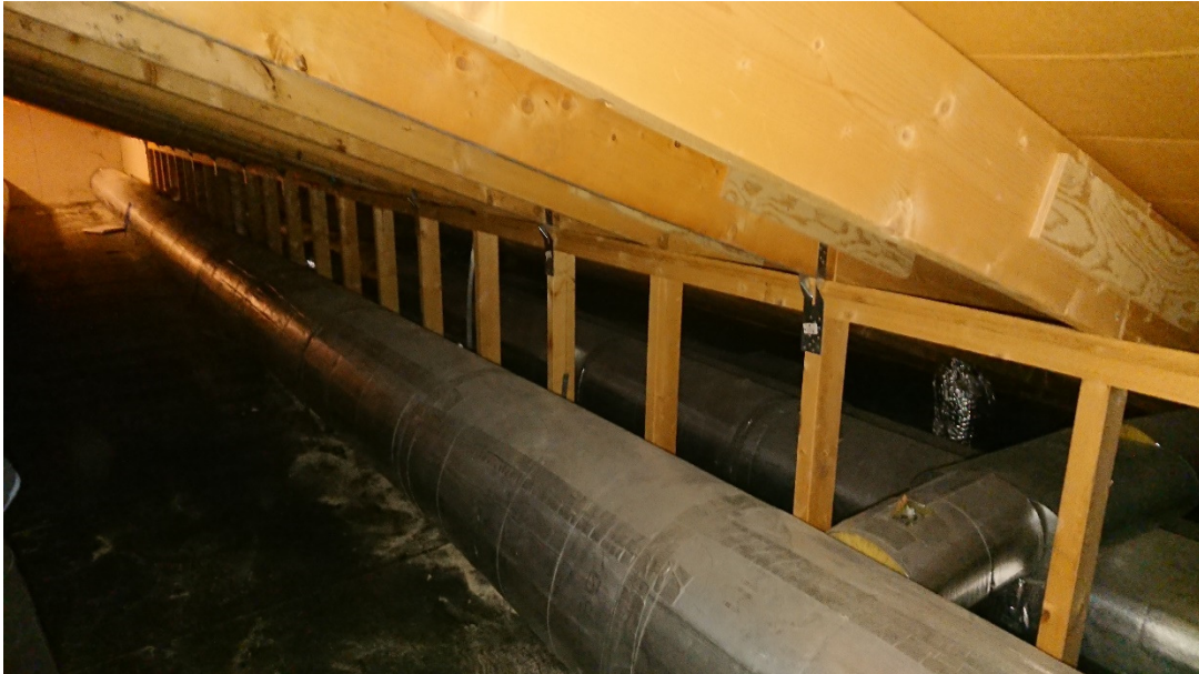
Bilde tatt takkonstruksjonen i akse G-H
