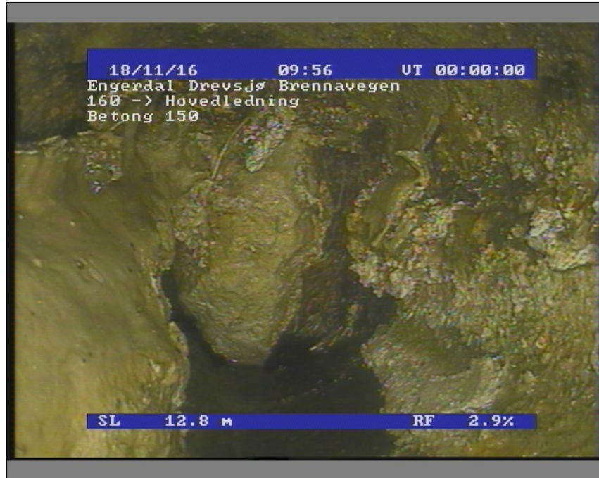
Foto: 21_21_237_A.JPG 12,9m, Utfelling/Belegg, reduksjon i tverrsnittsarealet 50% Reduksjon, fra 8 til 4 Kl., fett
