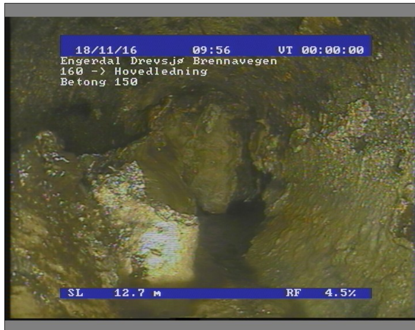
Foto: 21_21_237_B.JPG 12,9m, Utfelling/Belegg, reduksjon i tverrsnittsarealet 50% Reduksjon, fra 8 til 4 Kl., fett
