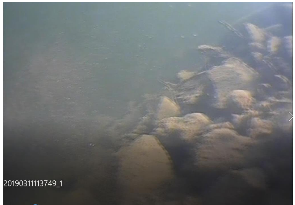
Like utenfor land. Stein i dekklag med grusige masser under.
