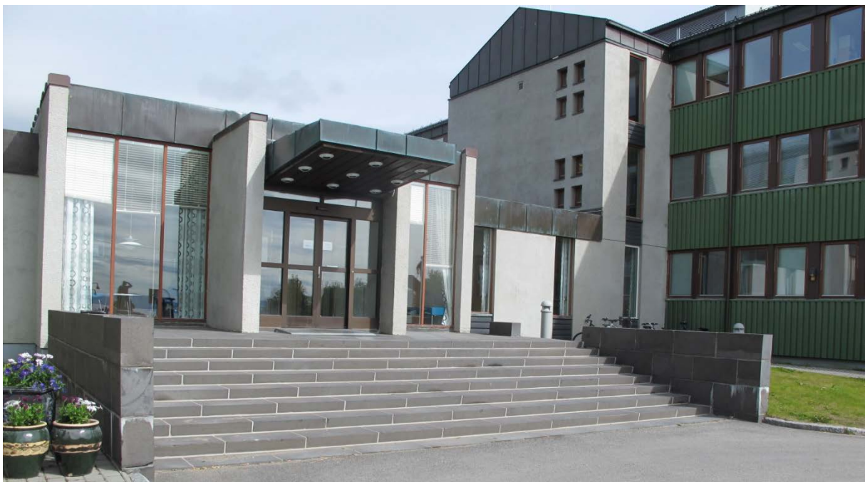
Mellombygg med inngangsparti, og vertikalkjerne inntil østre kontorfløy.
