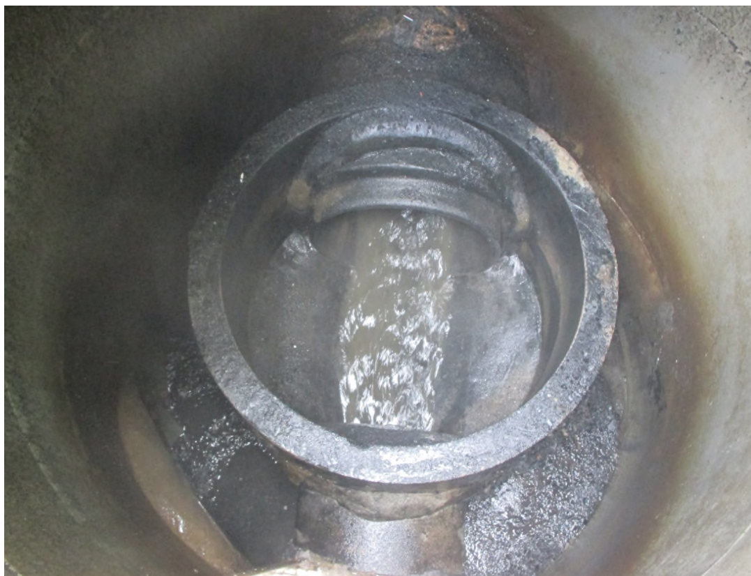
Figur 2 Viser bilde av overløpskum ved Alfheim. Ø600 betongrør kommer inn oppstrøms, utløp går via Ø400 betongrør til reguleringskum med videreført vannmengde ca. 90 l/s. Målt høyde fra innvendig topp Ø600 til overløpskant er ca. 20 cm.
