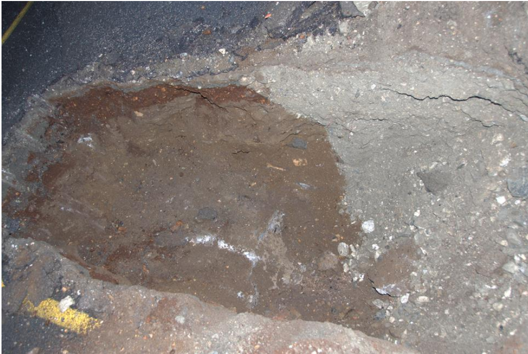
Prøvegrop 4. Dyp ca 1 m. Prøve nr. 5. Fyllmasser, litt murstein, betong.
