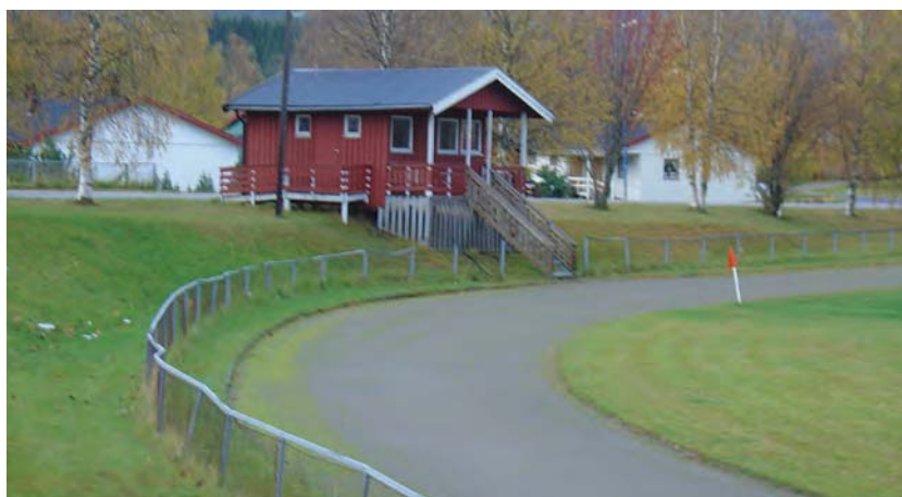
Figur 4.1.3: Her ser du to bilder fra Mediå stadion i Grong som er et grusanlegg. Foto: Ole Petter Sandvig
