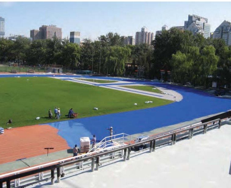
Figur 4.2.4: Rehabiliteringsarbeid av kunststoffdekker. Til venstre ser vi retopping av en løpebane (med Polytan Pur) i Beijing. Til høyre arbeides det med retopping av en løpebane i Pliezhausen i Tyskland. Margbildet viser oppmerking av en bane samme sted. Foto: Polytan GmbH
