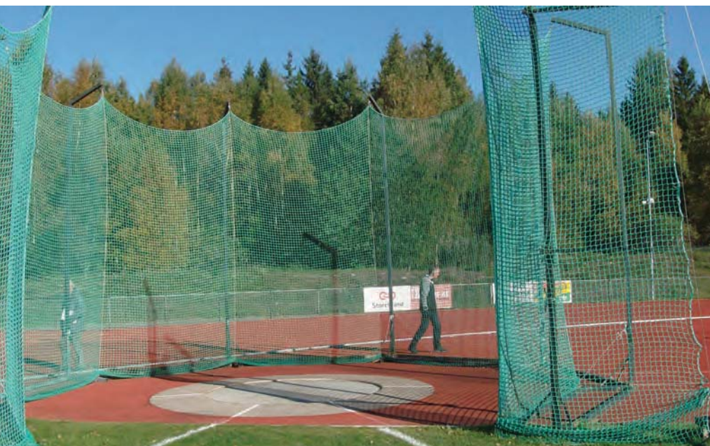
Figur 4.3.3: Dette nettet er kun egnet for diskoskast. Sleggekast fordrer et høyere kastbur. Buret på bildet står på Greveskogen idrettspark i Tønsberg. Foto: Ole Petter Sandvig
