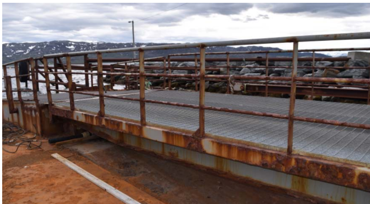
Bilde 7 – Generelt bru, venstre side 2
