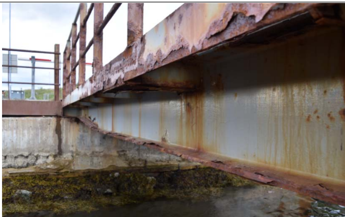
Bilde 8 – Generelt bru, høyre side 1
