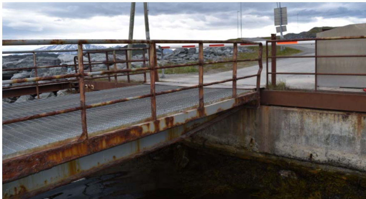
Bilde 6 – Generelt bru, venstre side 1
