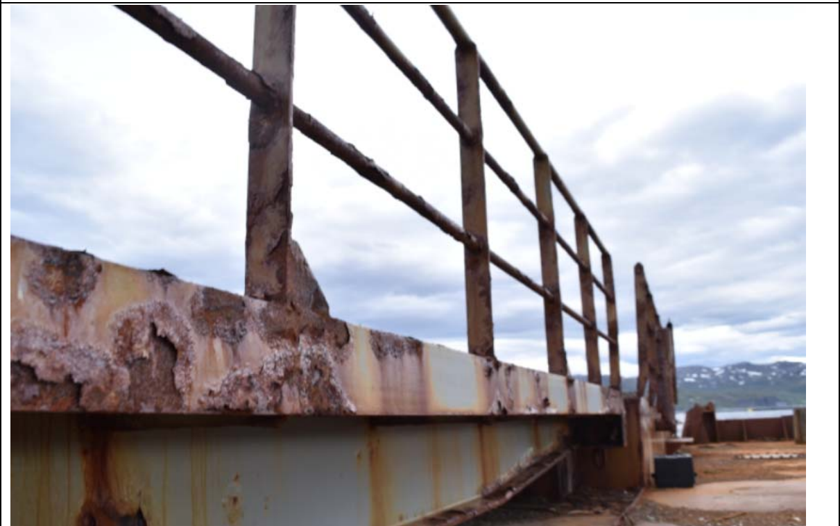
Bilde 9 – Generelt bru, høyre side 2
