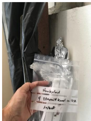
Figur 2.6: Prøvetatt ventila-sjonskanal 2. etg
