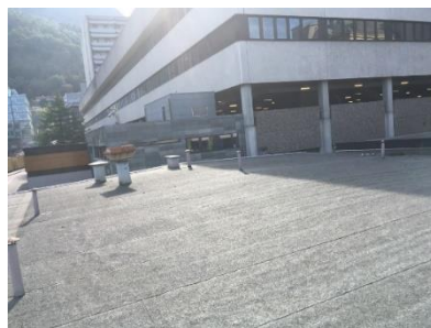
Figur 2.7: Kanaler på østsiden av bygget
