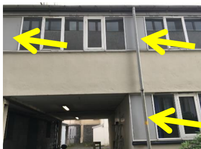
Figur 2.9: Ikke asbestholdige fasadeplater
