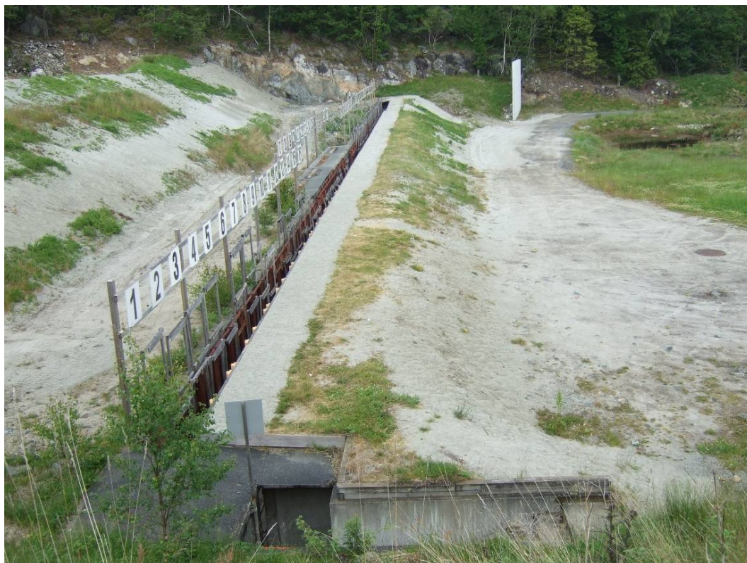
Bilde 7: Skivevoll og kulefangervoll på 200 m banen.
