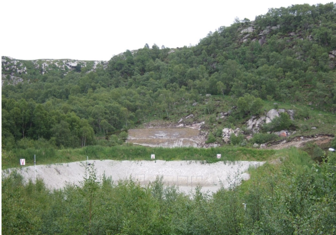
Bilde 10: Ny kortholdsbane i forgrunnen. Skive- og kulefangervoll til venstre og innskuddsområde i fjell til høyre i bildet.
