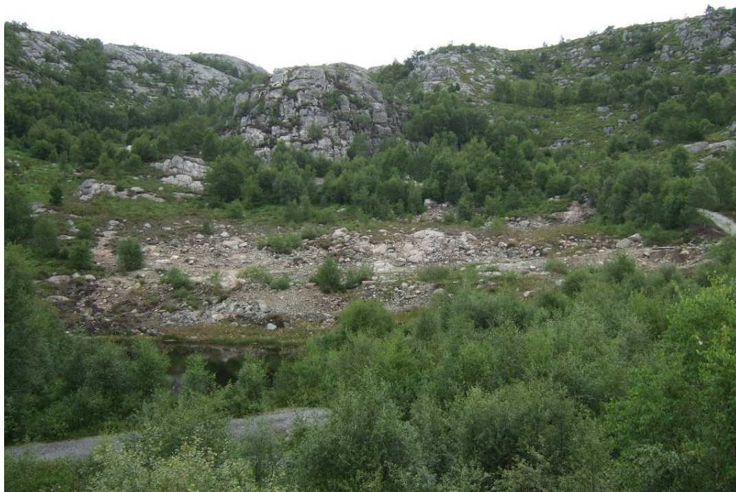
Bilde 13: Oversiktsbilde Felt B. Mye vegetasjon er ødelagt
