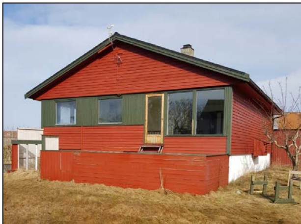
Figur 5: Bolighus, fasade sett fra sør.
