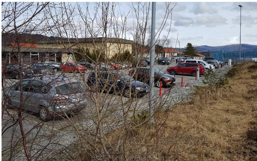
Figur 4: Forhøyning i terrenget sør for parkeringsplass, som vil motvirke eventuell avrenning fra bygget. Bygget som skal saneres sees i bakgrunnen (gult bygg). Bilde: Sweco.
