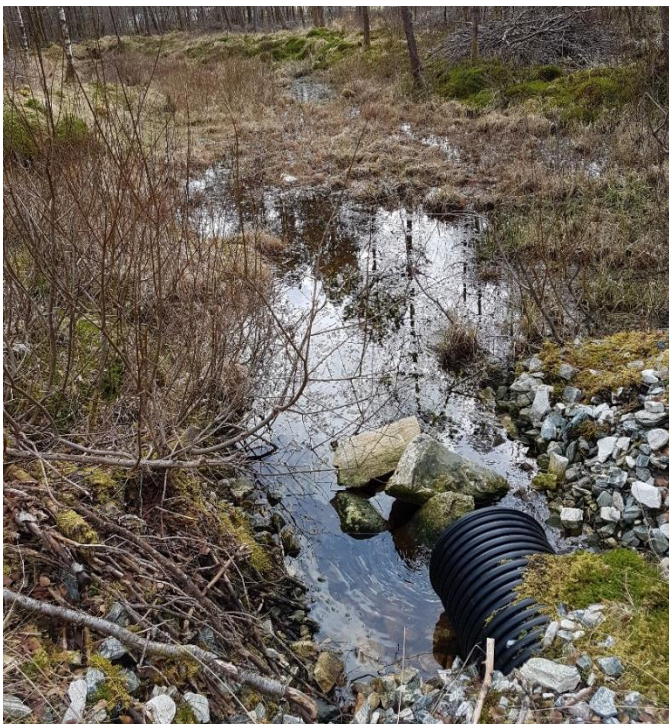
Figur 3: Rør ved starten av sidebekken til Haukåselva. Bilde: Sweco.
