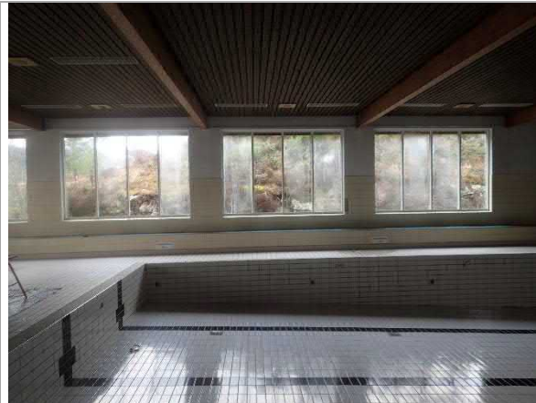
Figur 3.13.2 Vinduer i svømmehall med flere glassfelt.
