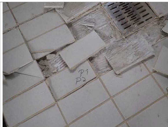
Figur 3.6.1 Fliselim lavforurenset med krom VI.
