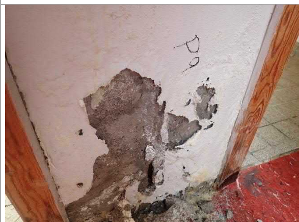
Figur 3.6.4 Grå maling i korridor lavforurenset med metaller.
