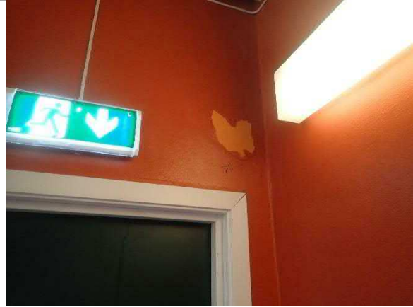
Figur 3.6.6 Rød maling i dusj lavforurenset med metaller.
