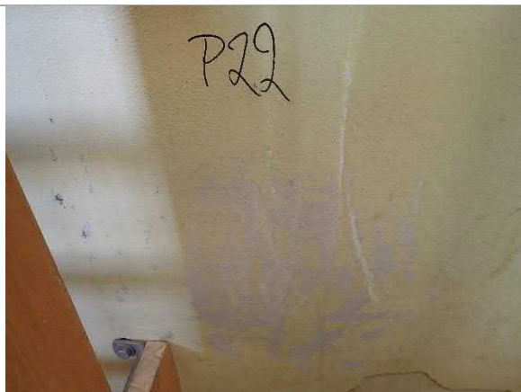
Figur 3.3.11 Grønn maling i gymsal lavforurenset med PCB.
