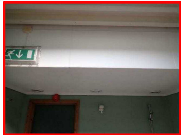
Figur 3.2.2 Eksempel på plater med asbest
