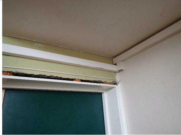
Figur 3.10.1 Bygningsskum over dør i gymsal.
