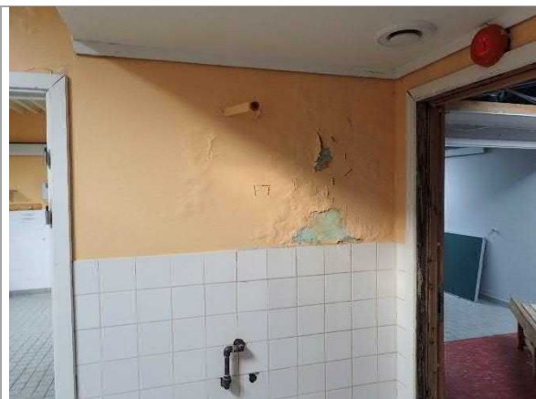
Figur 3.6.2 Gul maling lavforurenset med metaller.
