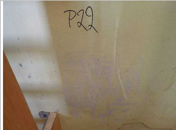
Figur 3.6.12 Grønn maling i gymsal, lavforenset med metaller.
