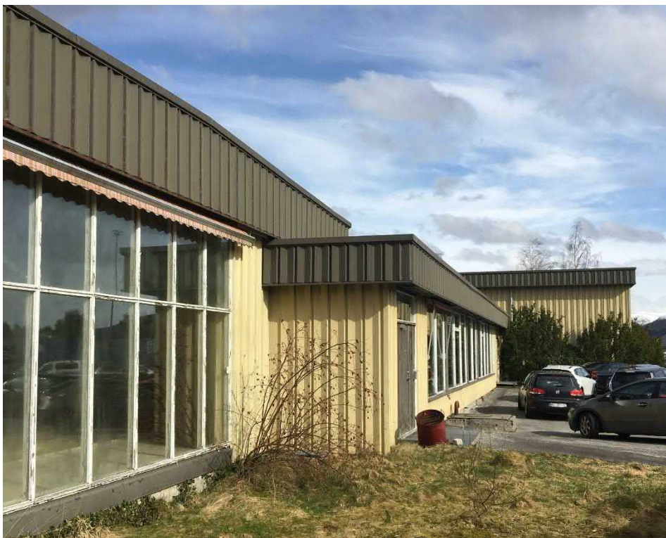
Figur 1.3.2 Fasade Bjørgvin fengsel bygg J.
