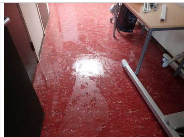
Figur 3.4.1 Eksempel på en type vinylbelegg fra bygget.
