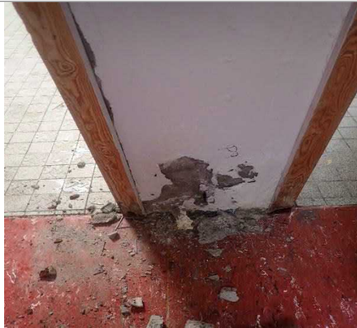
Figur 3.3.3 Grå maling i korridor lavforurenset med PCB.
