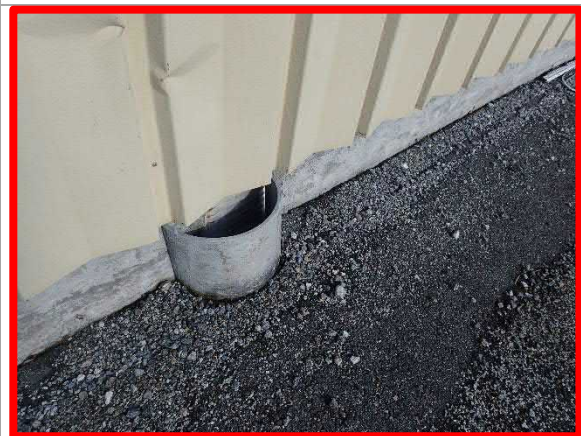
Figur 3.2.4 Halvt rør som går ned i bakken. Slike er spredd rundt hele bygget. Sannsynlig innhold av asbest.
