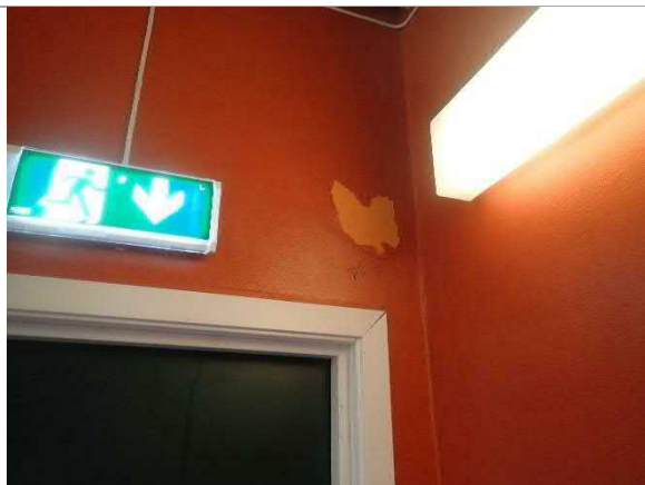
Figur 3.3.5 Rød maling i dusj forurenset med PCB.
