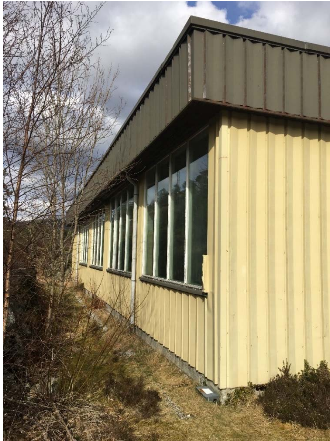
Figur 7 Fasade ved svømmehall
