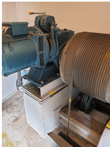
Figur 5. Heismotor
