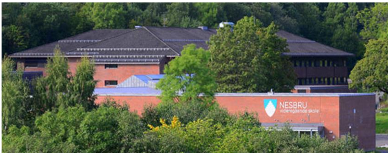
Nesbru videregående skole
