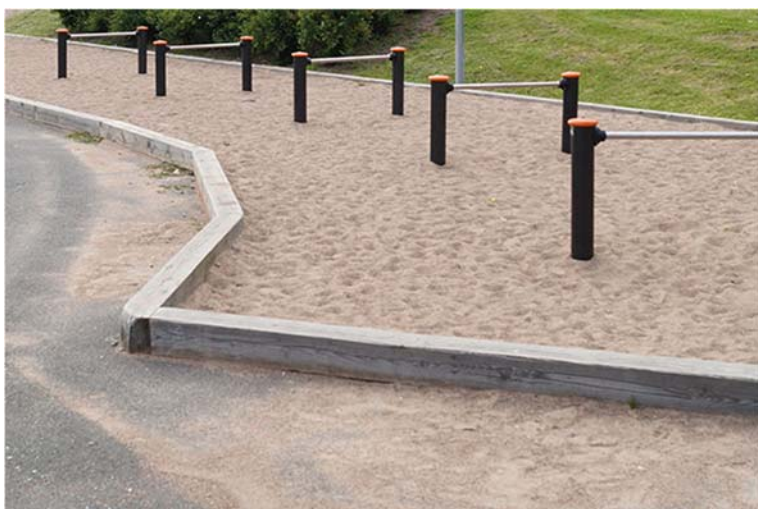
Eksempel på svillekant lagt som avgrensning mot asfalt.
