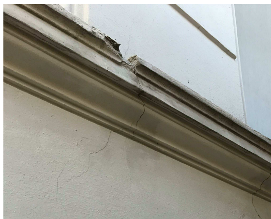
3. Riss/spekk skade
