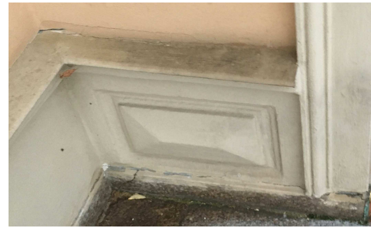
4. Sprekkskade
