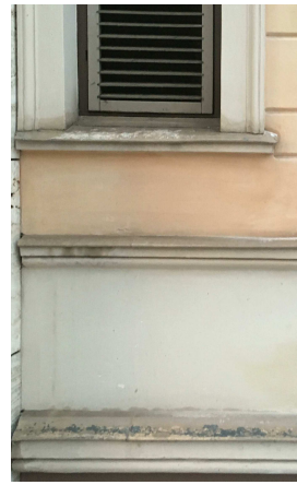
1. Skader på beslag
