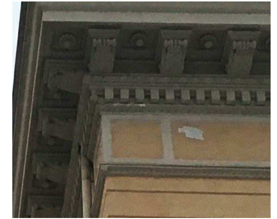
5. Fuktskade
