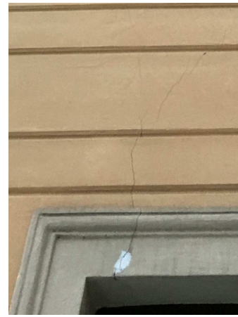
3. Riss/sprekk skade
