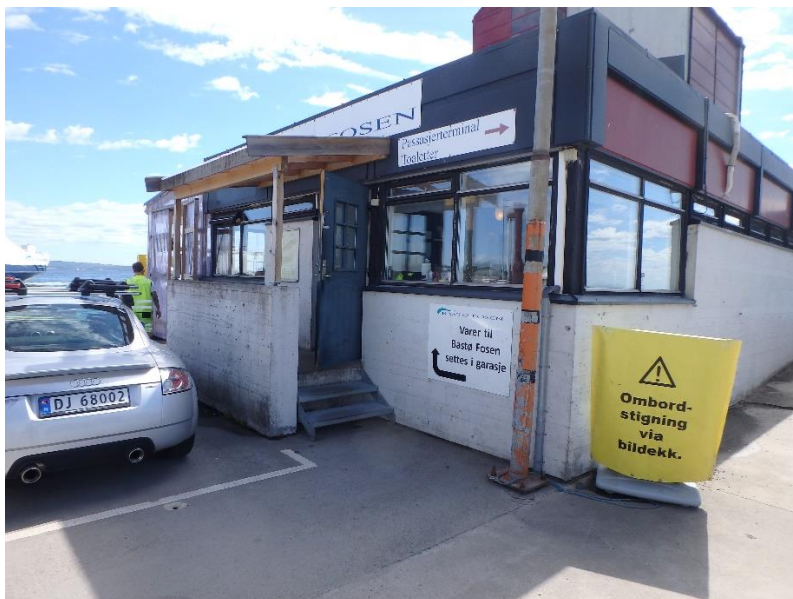
Figur 9 Vinduer i 1. etasje inneholder klorparafiner. Dette gjelder ikke de 4 store vinduene i venterommet (som ligger i den helt andre enden av bygningen i forhold til bildet.)
