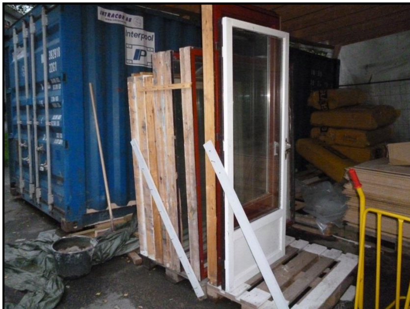
Figur 15: Slik kan vinduer og balkongdører klargjøres for transport.
