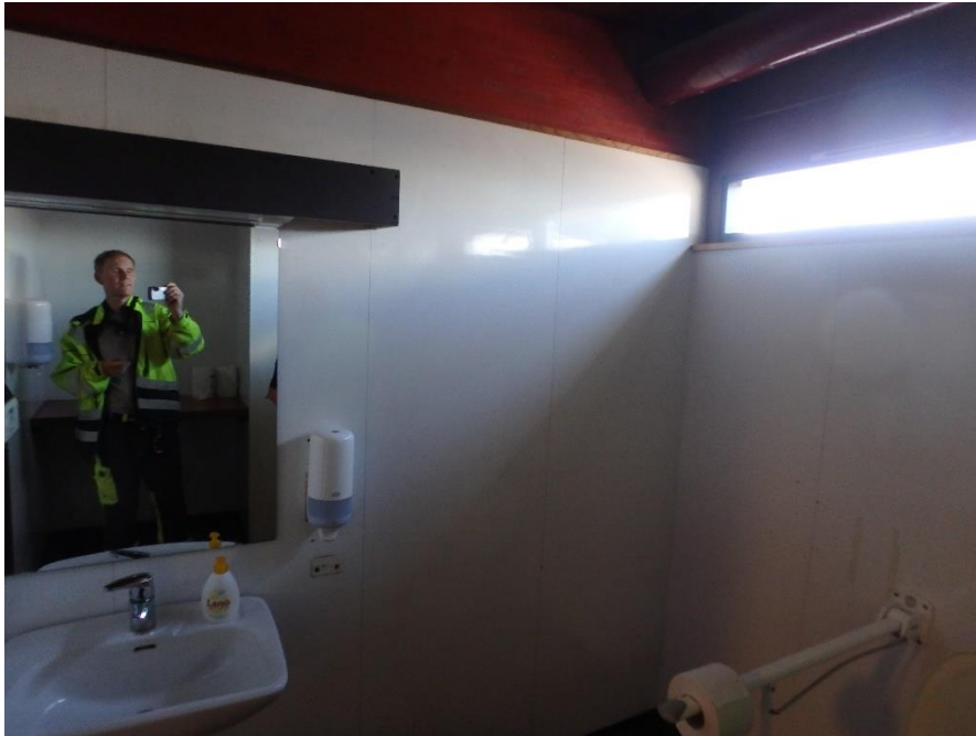
Figur 14 Baderomspanel med pentaklorfenol
