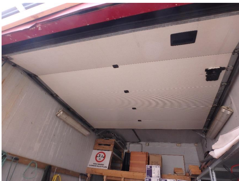
Figur 7 Garasjeport isolert med polyuretnakum med HKFK-gass
