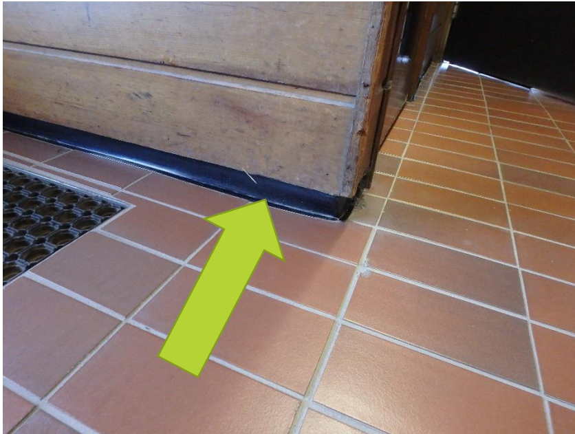
Figur 4 Svart vinyl gulvlist med ftalater
