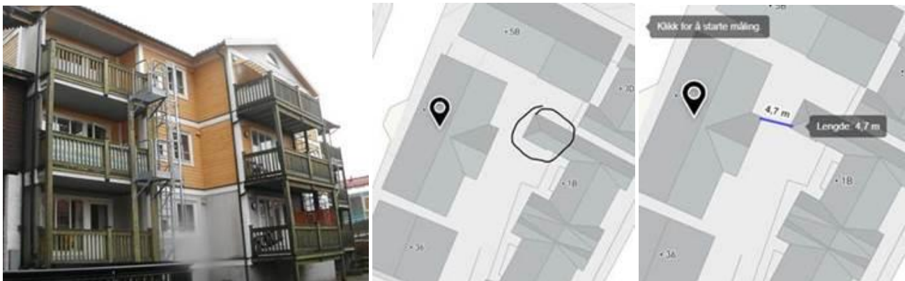
Figur 1 t.v. Stige med ryggbøyle ble godkjent i dispensasjonssak med vedtak 19.06.2004. T.h.: avstand mellom paviljong på nabobygg og omsorgsbolig er om lag 5 meter, noe som er under kravet på 8 meter. Sprinkling av fasade var av kommunen vurdert til god brannsikring her.
