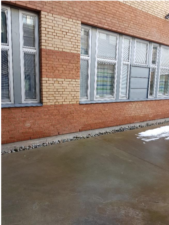
Figur 1. Utendørs betongdekke skal fjernes for å kunne utvide bygg C.
