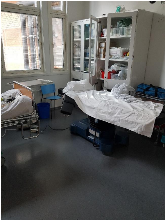
Figur 14. Strietapet er klassifisert som farlig avfall med ftalater (DEHP). Tapeten går igjen i flere rom i bygg C.
