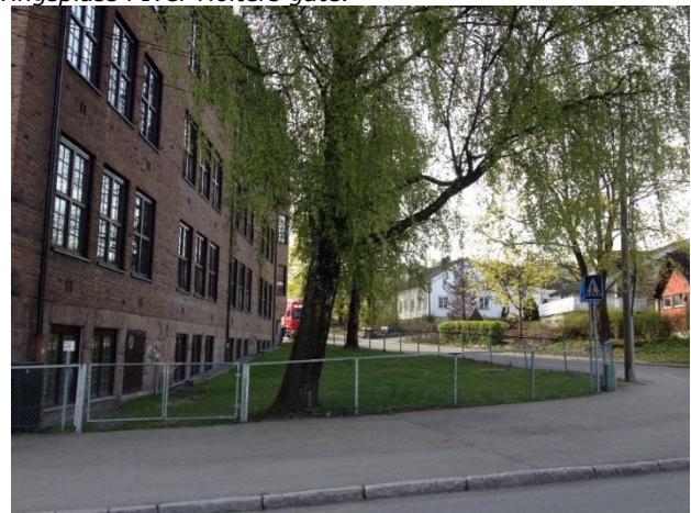
Til venstre: Brandengen barneskole, stengt med port ut mot Iver Holters gate og kryss med Holmestrandsveien. Over: Brandengen barneskole, fasade mot vest og Verven.
