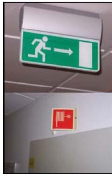
Bilde 20. Varselskilt for rømningsveg og brannutstyr (Foto: Brit Hassel)
