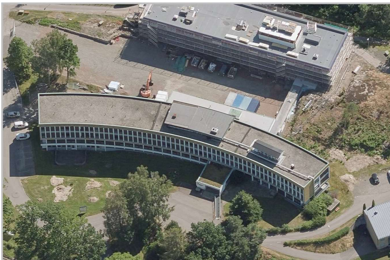
Figur 1 Gipø Vest (krum bygning) sett fra vest
