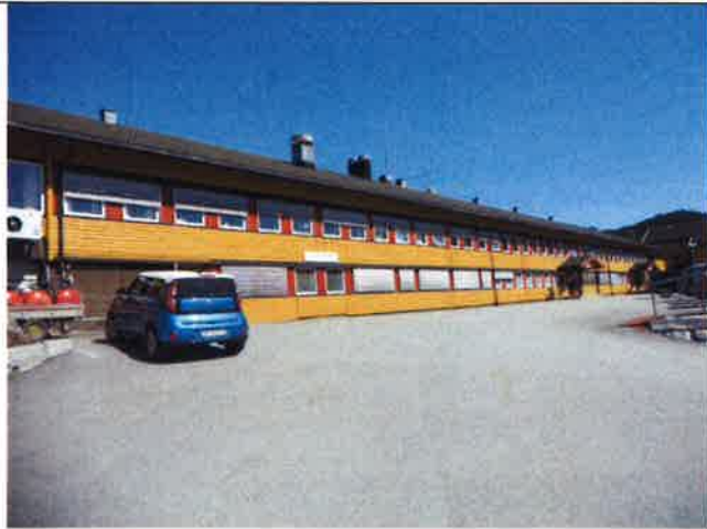
1974-bygget er et langt bygg i 2 etasjer og et stort loft med tekniske rom.
