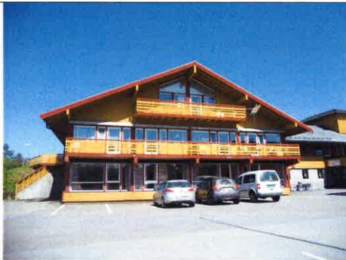
1984- bygget i 2 etasjer samt en loftsetasje
