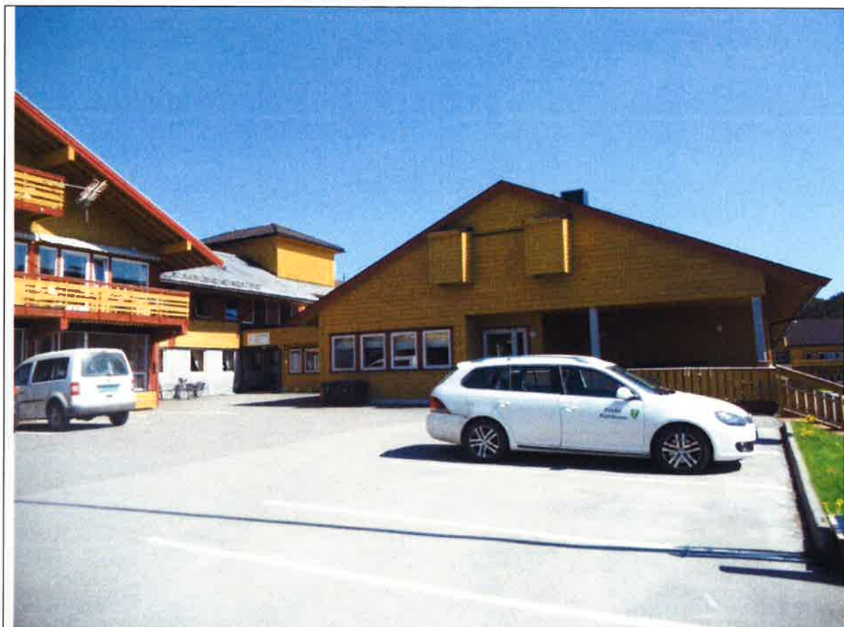
Hovedinngangen ses inne i kroken samt at man ser gavlveggen av 1974 – bygget med tilbygg fra 2001 nærmest. Anbefalt grensesnitt ses dermed inne i kroken av bygget.
