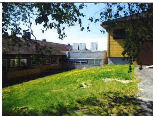
Kjøkkenet ses som et mellombygg i grått.
