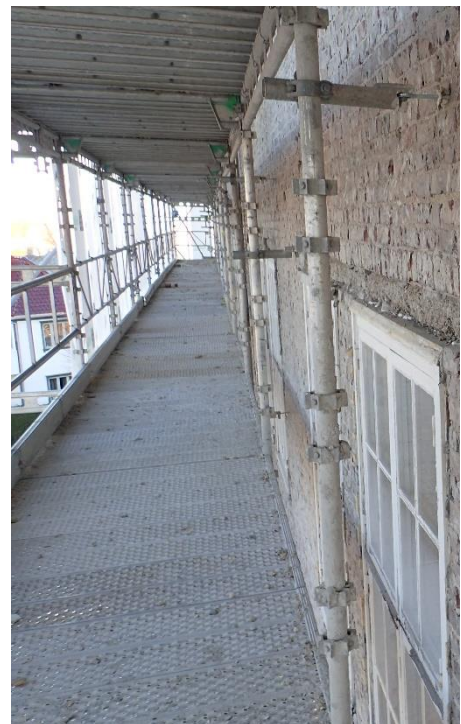
Figur 1 – Eksempel på tungstillas, her med tverrgående dekkeprofiler.
