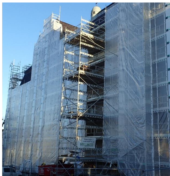
Figur 3 – Eksempel på lasteplattformer for hvert 2. stillasnivå.
