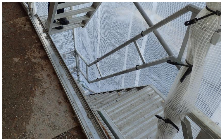
Figur 2 – Eksempel på trappetårn utenpå tung stillas.
