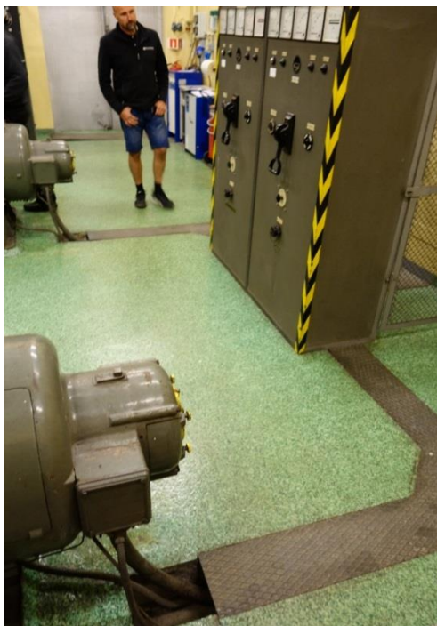
Bilde nr.4: Eksist. styreskap med gruber inn/ut i gulv.
