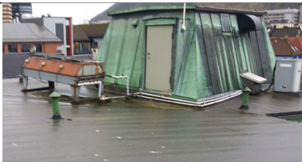
103 Oppbrett innunder NY båndteking på fasade takoppbygg 2.
