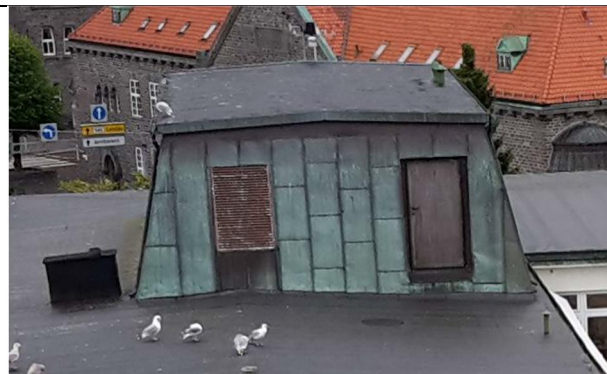
102 Oppbrett innunder NY båndteking på fasade takoppbygg 2.
