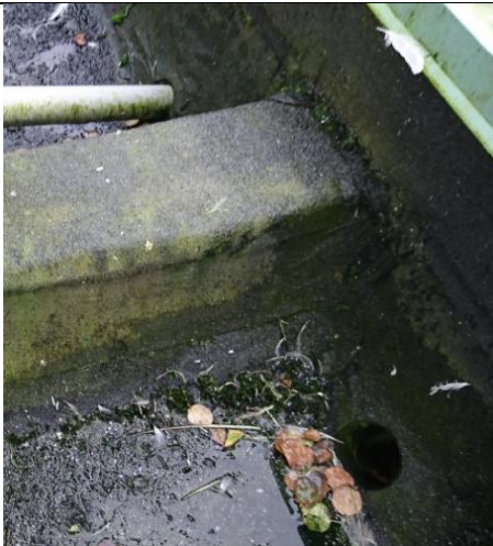
113 Inntekking av gjennomføring for avrenning tak
