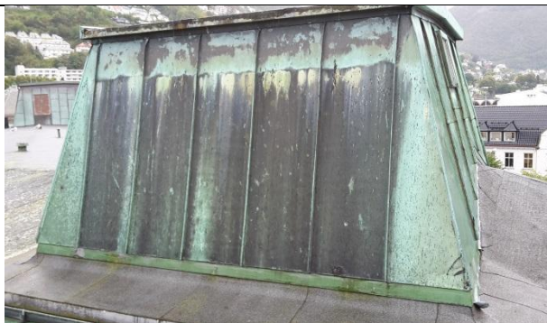
101 Oppbrett innunder NY båndteking på fasade takoppbygg 1.
