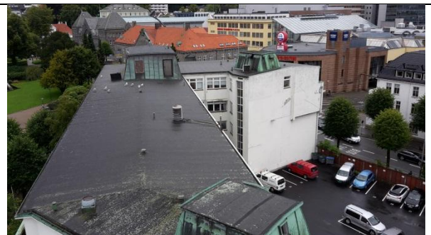
104 Takoppbygg 1, 2 og 3. Takhatter og inntekkinger.
