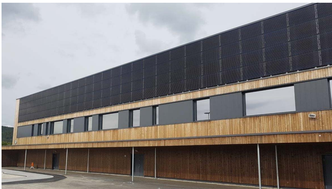
Figur 4: Eksempel på fasadeintegret anlegg (Bjørkelangen skole)
